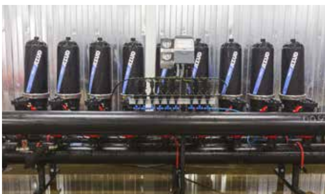
Автоматический дисковый фильтр с автоматической промывкой. ООО «Ягодная Долина»
